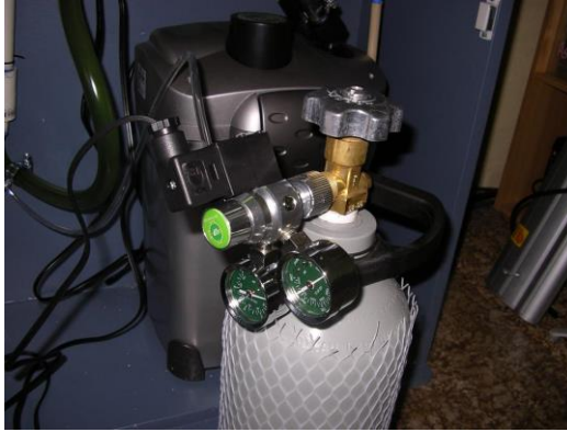
Rys. 6. Butla z dwutlenkiem węgla z podłączonym elektrozaworem [9]
