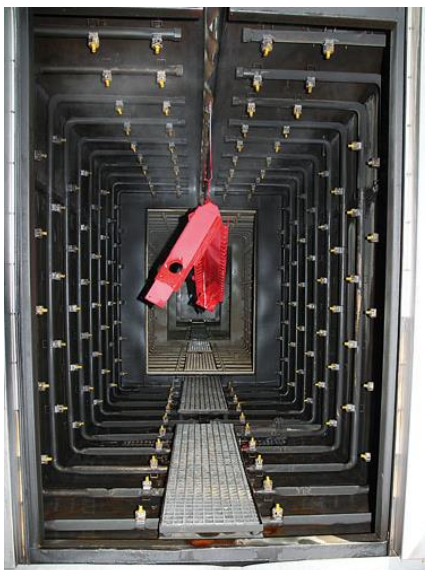
Rys. 2. Tunel przygotowawczy - widok wewnętrzny (opracowanie własne na podstawie [10])
